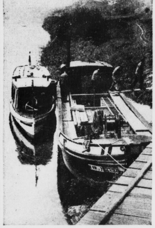
Die „Merseburg“ neben einem Baukahn.
