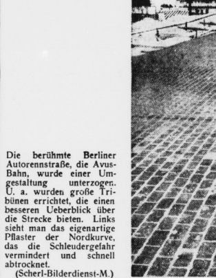
Die berühmte Berliner Autorennstraße, die Avus-Bahn, wurde einer Umgestaltung unterzogen. U. a. wurden große Tribünen errichtet, die einen besseren Überblick über die Strecke bieten. Links sieht man das eigenartige Plaster der Nordkurve, das die Schleudergefahr vermindert und schnell abtrocknet. (Scherl-Bilderdienst-M.)
