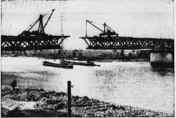
Zwei Brückenenden wachsen zueinander. Eine interessante Aufnahme von dem Bau der Brücke über die Elbe auf der Reichsautobahnstrecke Berlin-Hannover. Der Brückenbau wurde gleichzeitig von zwei Ufern begonnen, und jetzt treffen in der Mitte die beiden Brückenteile zusammen. (Scherl-Bilderdienst-M.)
