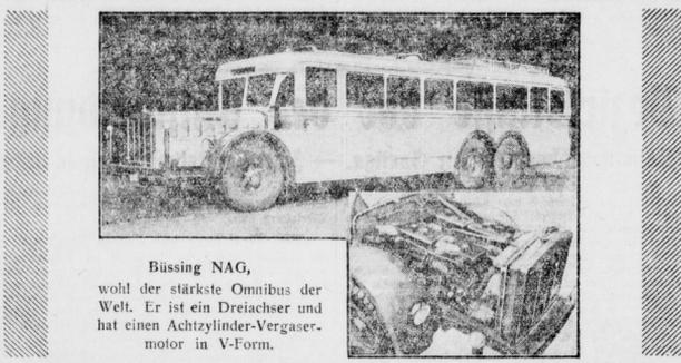
Büssing NAG, wohl der stärkste Omnibus der Welt. Er ist ein Dreierachser und hat einen Achtzylinder-Vergasermotor in V-Form.
