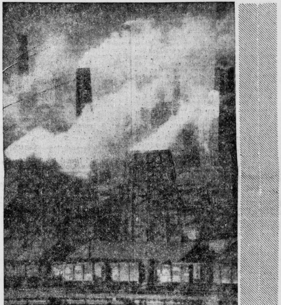
Alle Schloten sollen wieder rauchen...
