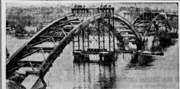
Triumph deutscher Technik in Schweden. Die neue West-Brücke in Stockholm, die größte Brücke Schwedens, geht ihrer Fertigstellung entgegen. Die 1600 m lange und 24 m breite Brücke mit ihrer schwierigen Konstruktion wird von einer deutschen Baufirma errichtet...
