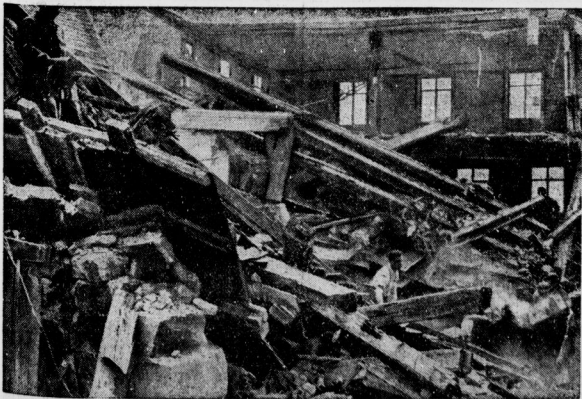
Das furchtbare Einsturzungsunglück in der Schule von Winterbach. Blick auf die Trümmer der alten Schule in dem württembergischen Ort, die während des Unterrechts einstritzte. Der Hauptlehrer Kohle und sieben Kinder wurden von dem herabstürzenden Mauerwerk erschlagen. Vier Kinder wurden schwer, zwölf leichter verletzt.
