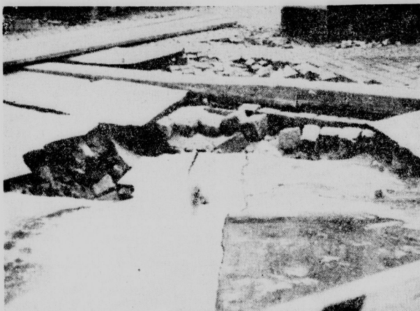
Die ungeheure Gewalt der Wassermengen reißt das Straßenpflaster weithin auf. (Bild: Ziegler.)
