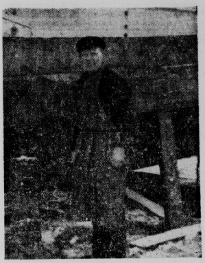
Ausbesserungsarbeiten am Kahn. (Bilder: Martin)
