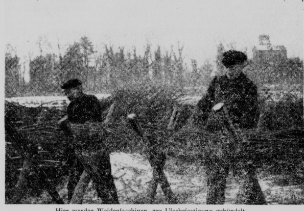
Hier werden Weidenfischchen zur Uferbefestigung gebündelt.
