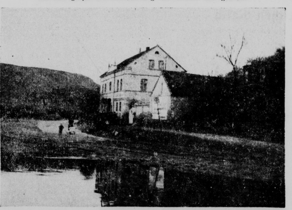
Langsam gleitet die Fahre von Brücke herüber nach Rothenburg, begleitet von Donnerschlägen, die sich wie Salutschüsse anhören und dabei doch nur von den Sprengungen bei Nelben herühren, wo jetzt die neue Saale-Schleuse entsteht. (Aufnahme: Herbert Kunze.)
