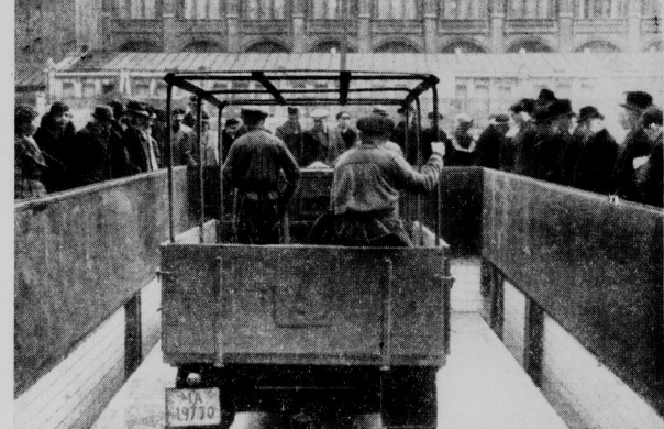
Mit Staunen bemerken häufig Passanten, wie plötzlich in der Vofstraße vor der Neuen Reichskanzlei ein Lastkraftwagen oder ein Pferdewerk in die Erde versinkt. Dort befindet sich nämlich, kaum erkennbar, unter den großen Steinplatten der Straßendecke ein Fahrstuhl, der sich durch Druck auf einen Knopf mit dem Fahrzeug um eine Etage senkt und dort seine Last abläßt. Sobald sich das Fahrzeug zu senken beginnt, hebt sich ein meteorisches Schutzgitter über die Straßenoberfläche.
