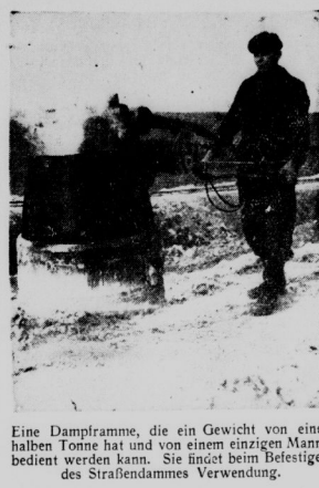
Eine Dampfmaschine, die ein Gewicht von einer halben Tonne hat und von einem einzigen Manne bedient werden kann. Sie findet beim Befestigen des Straßendammes Verwendung.
