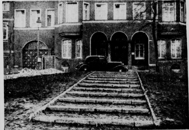
Die neue Treppe, die von Moritzwinger Markt zum Elisabeth-Krankenhaus führt.
