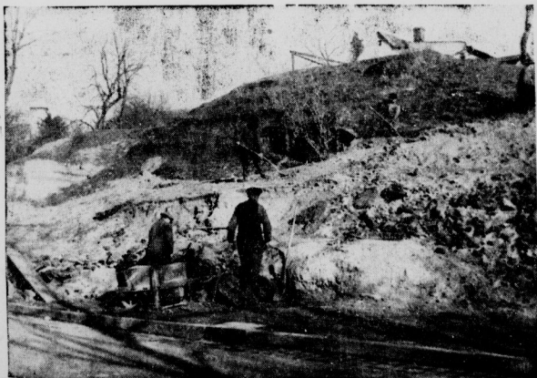
Hier oben entsteht der Lindenplatz.
