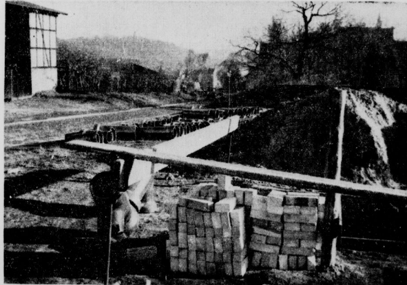
Blick in die Lettiner Straße, in der ein neuer Wasserleitungsstrang gebaut wird. Im Vorder- grund Steine und Erden für die Verbindungsstraße von der Lettiner zur Dölauer Straße.
