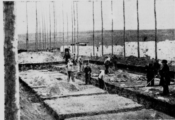
Hier entstehen Gaglach-Siedlungshäuser an der Mätzlicher Straße. (Bilder: Ziegler.)
