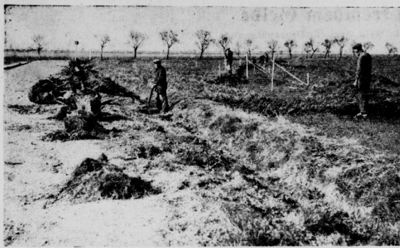
Von den hallischen Siebelwerken aus wird die Straße nach Oppin, die bisher in sehr schlechtem Zustand war, erneuert und wesentlich verbreitert...
