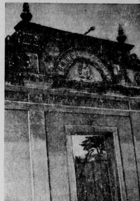
Von der Schule in Manaos wurde nur die Fassade fertig.
