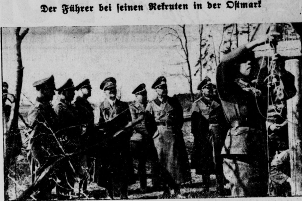
An einer Brücke wird eine Sprengladung angebracht. Weltbild.
