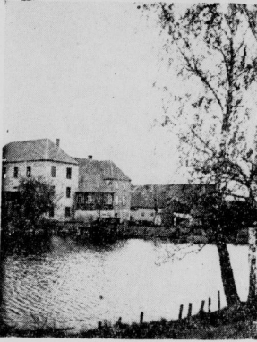
Die ausgebrannten Gebäudeteile der Mühle werden ausgebaut (Bild: Müller)
