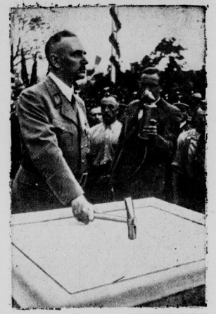
Reichsminister Rust vollzog auf dem Westmarkt-Gauzug 1939 in Trier die Grundsteinlegung zur Hochschule für Lehrerbildung. Weltbild (K).
