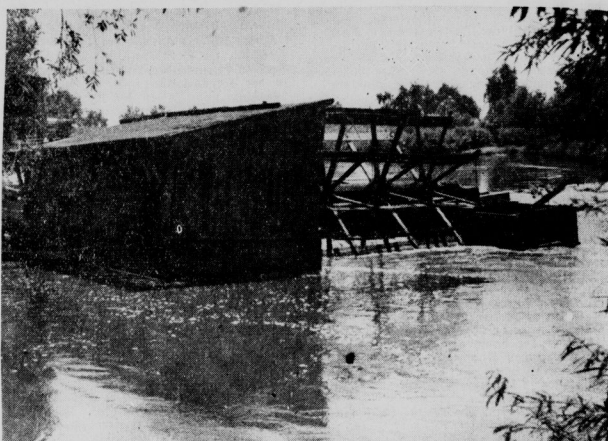
Weit vom Ufer der Mulde entfernt, liegt die Schiffsmühle im Fluß verankert.
