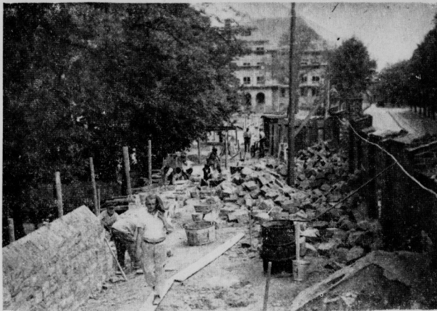
Im Zusammenhang mit dem Bau der Volfstraße durch den östlichen Teil der Franckeschen Stiftungen wird auch die Lindenstraße eine erhebliche Verbreiterung erfahren. Wie unser Bild zeigt, ist man zur Zeit dabei, hinter der bisherigen Mauer der Franckeschen Stiftungen eine neue Mauer aufzurichten. Nach ihrer Fertigstellung wird die alte Mauer eingerissen und die Lindenstraße mit das neugewonnene Stück Boden verbreitert. (Bild: Ziegler)
