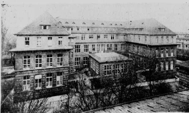
Die hallische Universitäts-Augenklinik in der Hindenburgstraße. (Aufn.: Hochbauamt.)
