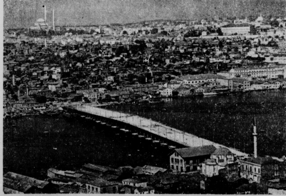
Ende Oktober wurde die zweite Schwimmbrücke über das Goldene Horn in Istanbul, ein Meisterstück deutscher Technik, dem Verkehr übergeben. Sie ersetzt eine von den Engländern gelieferte und durch Sturm zerstörte Pontonbrücke. Weltbild (K.)
