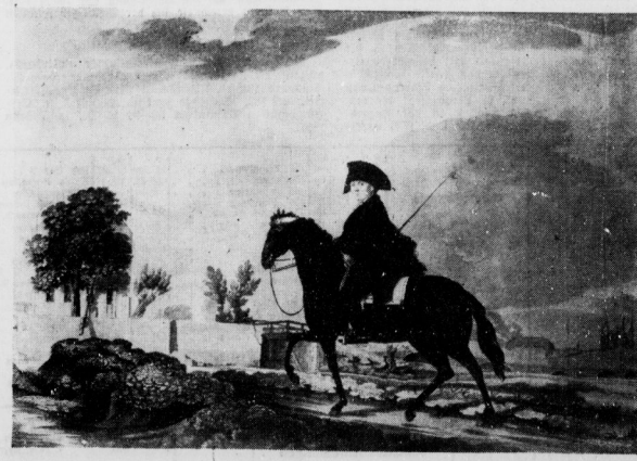
So sah es vor etwa hundert Jahren vor den Toren Halles aus. Das Bild zeigt im Vordergrund hoch zu Ross eine damals stadtbekannte Persönlichkeit, den Stadtrat Schier. Im Hintergrund links die heutige Schillerbrücke, die damals hohe oder schwarze Brücke genannt wurde. Rechts am Horizont die fünf Türme, die Wahrzeichen Halles. Links hinter der Kastanie erkennt man die Plännerschicht mit dem alten Zollhaus.
