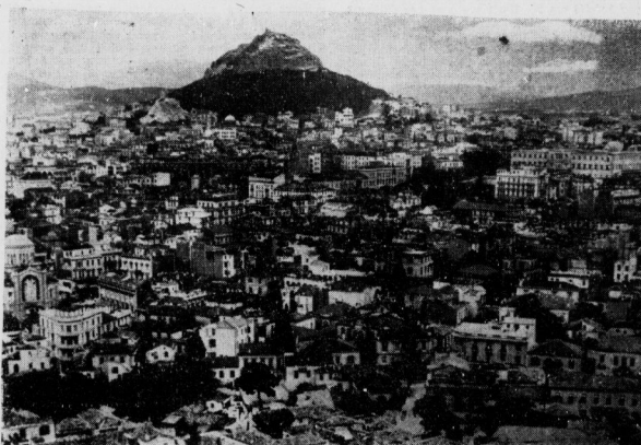
Blick von der Akropolis auf Athen mit acht- bis zehnstöckigen, die Umgebung weit überragenden Neubauten. Im Hintergrund der Kallitatos
