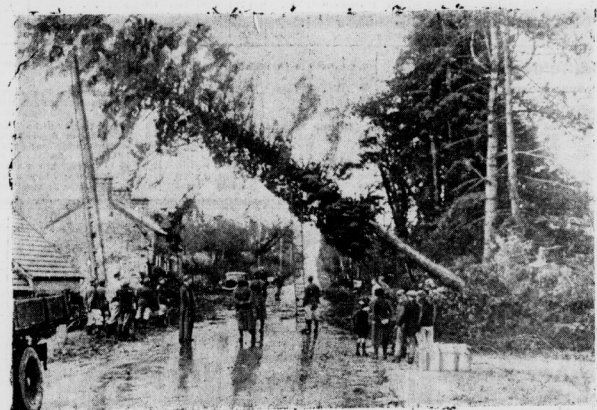
Sturmschäden an der Kanalküste
