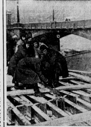
Trotz des Winters arbeiten die Baukompanien eifrig weiter an der Errichtung von hölzernen Notbrücken in den befreiten Ostgebieten
