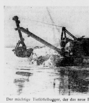
Der mächtige Tiefstößelbagger, der das neue Flußbett schaffen half
