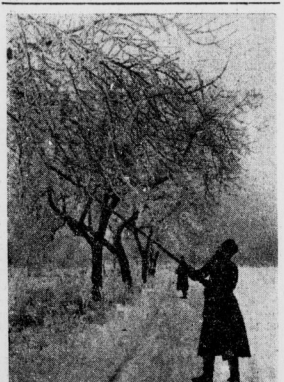
Mit dem Telefonkabel nach vorn Eine Aufnahme von unseren Nachrichtentruppen im Westen. Durch die Zweige der Bäume wird das Kabel mittels Stangen verlegt.
