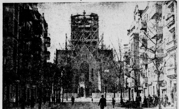
Ein Kirchturm verliert seine Spitze Mit Rücksicht auf den Flugverkehr des benachbarten Flughafens mußte jetzt der 60 Meter hohe Turm der Neuköllner Genezarethkirche auf dem Herrturnplatz in Berlin-Neukölln um etwa 20 Meter abgenommen werden
