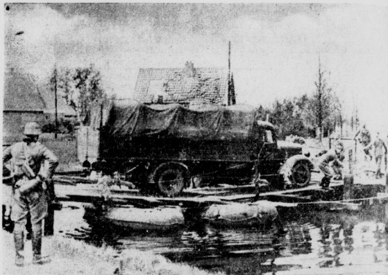
Wenige Stunden vorher hatten die Holländer hier eine Kanalbrücke gesprengt. Schon geht über die von unseren Pionieren errichtete behelfsmäßige Brücke der motorisierte Nachschub
