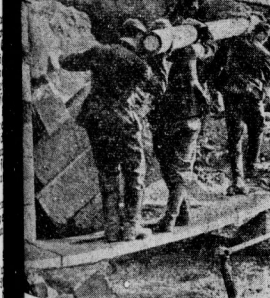
Deutsche Pioniere bauen eine Notbrücke über die Ourthe in Belgien
