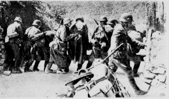
Straßensperre wird beseitigt. Im Handumdrehen sind die Sperrbalken beseitigt und der Vormarsch geht weiter
