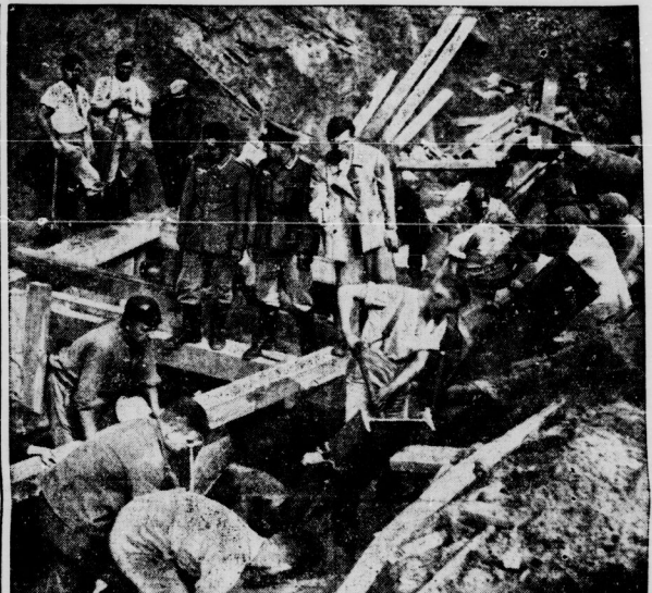
An der Unglücksstelle in der Hermann-Göring-Straße in Berlin wird fieberhaft weiter gearbeitet. Auf Veranlassung des Reichministers Dr. Goebbels waren aus dem Ruhrgebiet Spezialbergleute zu den Rettungsarbeiten nach Berlin berufen worden. Jetzt arbeiten die Ruhrkumpels Hand in Hand mit den Rettungsmannschaften an der Bergung der Opfer in der Hermann-Göring-Straße. Man sieht sie hier beim Bau eines Stollens, der bergmännisch angelegt wird. (Scherl-Bilderdienst-M)
