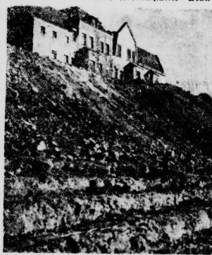
Die Erdarbeiten an der neuen Kampfbahn sind fast vollendet. Sie lassen schon deutlich die Besonderheit der neuen Anlage erkennen: Platz für 25 000 Zuschauer.
