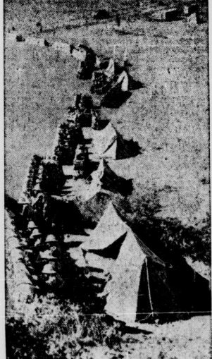
So sichert Italien seine Nachschubstraßen. Das Hauptgewicht der italienischen Vormarschbewegung in Abessinien ist die Sicherung des Nachschubs, die durch den schleunigen Neubau von Straßen durchgeführt wird. Zur Sicherung dieser Straßenbauten, die man im Hintergrund sieht, haben sich die Italiener hinter Sandackbarrikaden verschanzt.
