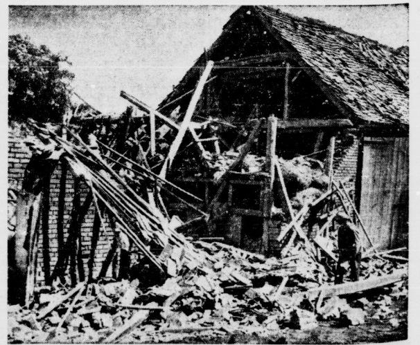
Die Wirkung der Explosion in Reinsdorf. Das Explosionsunglück in den Reinsdorfer Sprengstoffwerken hat auch in der näheren Umgebung Verheerungen verursacht. Unser Bild zeigt ein schwer betroffenes Bauerngehöft in Braunsdorf. (Scherl.-M.)
