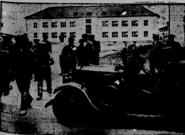
Am der Heeresnachrichtenschule Halle: Im Hintergrund ein Wohngebäude. Arbeiter besichtigen voll Interess die eben eingetrossenen Kräftewagen.
