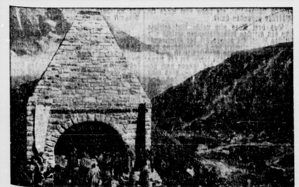
Die soeben eröffnete Hochalpenstraße über den Großglockner. Man sieht auf unserem Bild das Denkmal beim Fuscherlö, das den bei diesem Bau verunglückten Arbeitern gewidmet ist. (Scherl-M.)
