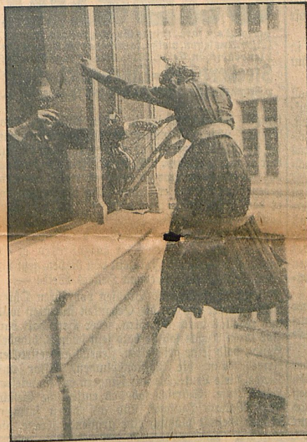
Ein neuer Feuer-Rettungsapparat. Der Berliner Feuerweh wurde kürzlich ein neuer Feuer-Rettungsapparat vorgeführt. Der Apparat besteht aus einem mit Rettungswagen versehenen, am Fenster befestigten automatischen Flaschensystem, an dem sich im Falle der Gefahr Personen herablassen können.
