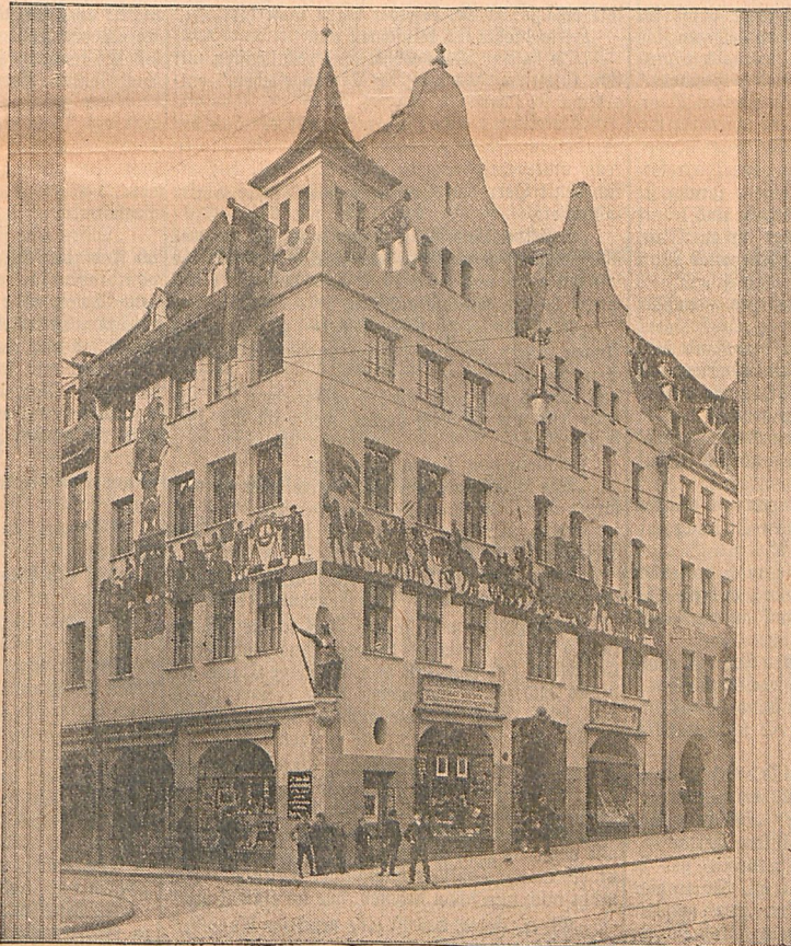
Das neue Handelskammergebäude mit Freskodarstellungen aus dem alten Handelsleben.
