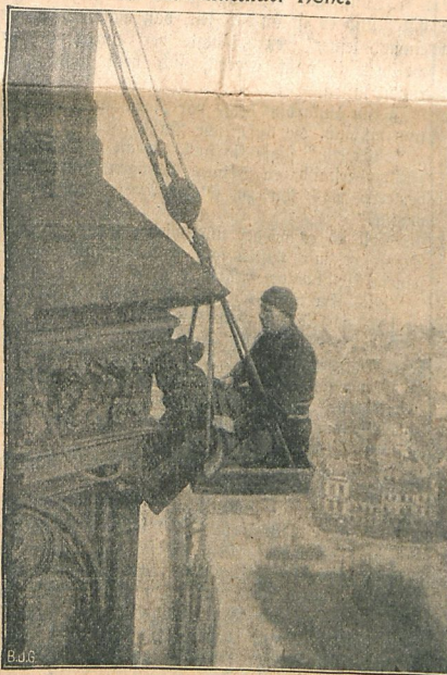
Arbeiten an der Spitze des Kölner Dom-Turmes.
