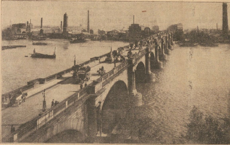
Die Londoner Waterloo-Brücke wegen Einsturzgefahr gesperrt. (Mit Text.) [Atlantico.]
