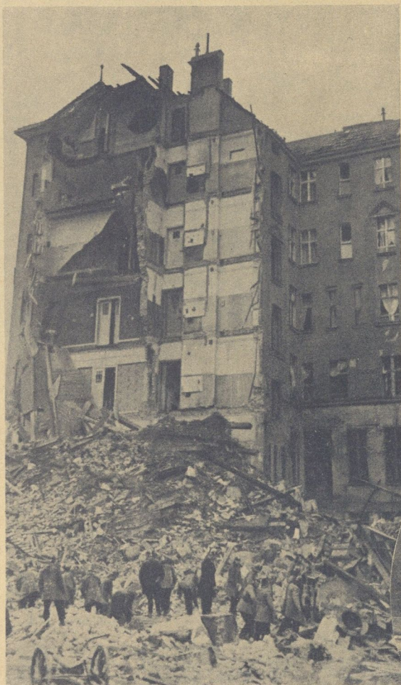
Große Explosionskatastrophe in der Landberger Allee, Berlin, verursacht durch ein schabhaftes Hauptgasrohr, bei welcher 7 Tote und 17 teils Schwerverletzte bisher geborgen wurden. [D. Fr.-W.-B.]
