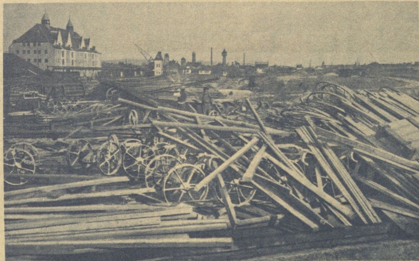
Große Wirbelsturm-Katastrophe in Nordbayern Die Verwüstungen im Bamberger Hafen. Im Vordergrund eine vollständig zerstörte Halle für landwirtschaftliche Maschinen. [Photobet]
