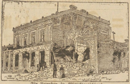
Die Unruhen in Mitteldeutschland. Der Bahnhof Gießhölz nach der Sprengung durch die Kommunisten.
