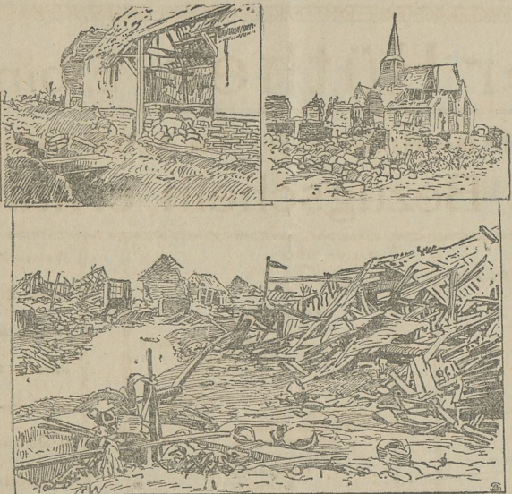
1. Das zerstörte Maame. 2. Zerstörte Häuser in Vignacq. 3. Ruinentrümmer von Bequincourt.
