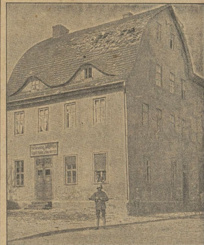
Zeitfreiwilliger vor zerhobenem Haus in der Mansfelder Straße
