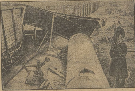
Der explodierte Phosgen-Tank
